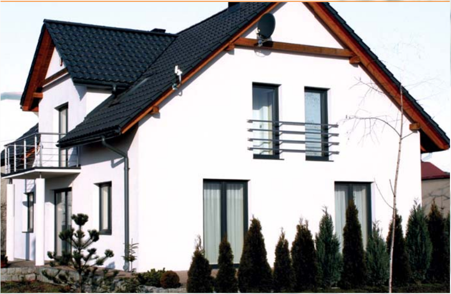
Jeden z pierwszych pasywnych budynków ocieplony styropianem Termo Organika
