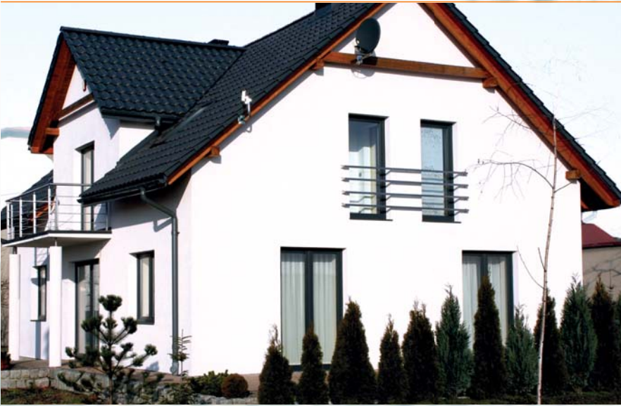
Jeden z pierwszych pasywnych budynków ocieplony styropianem Termo Organika
