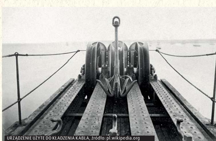
URZĄDZENIE UŻYTE DO KŁADZENIA KABLA, źródło: pl.wikipedia.org
